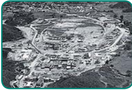
Construcción de la Ciudad Universitaria 1945 Fuente: www.bicentenario.gob.ve .
