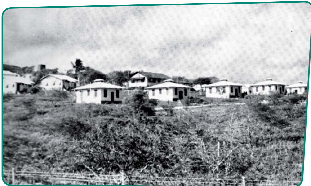
Área habitacional para familias obreras en Cumarebo. Cercado delimitador del área.
