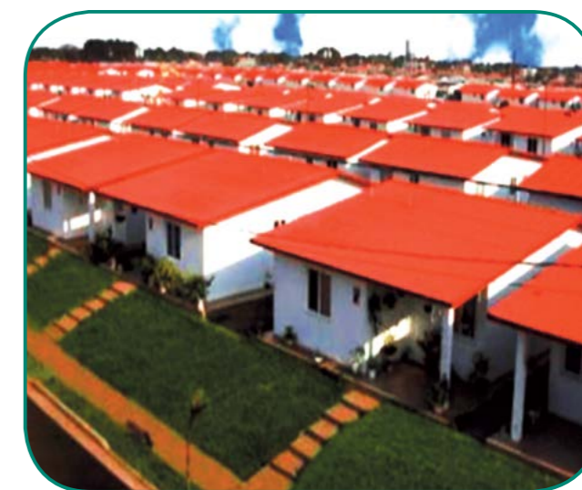
Petrocasa es uno de los tipos de viviendas populares que se construyen en Venezuela. ¿Por qué se les denomina viviendas dignas? ¿Por qué se les denomina Petrocasas?
