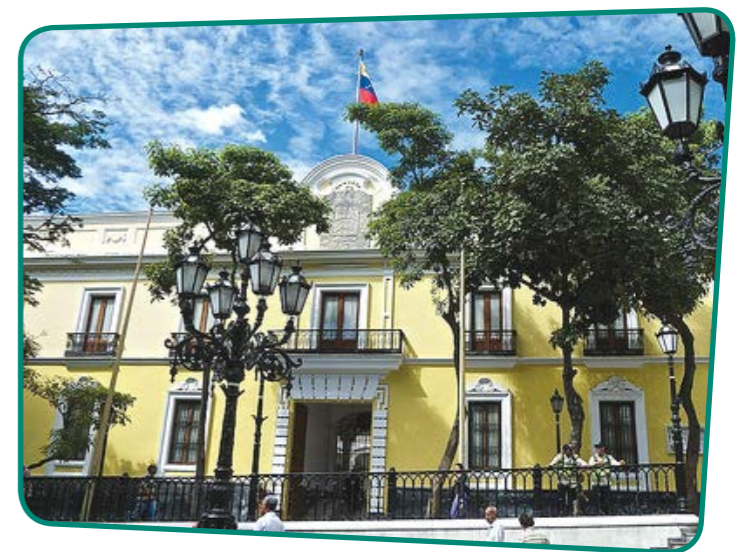
Al Cabildo de Caracas se le construyó esta sede, frente a la plaza Mayor. Actualmente la ocupa el Ministerio de Relaciones Exteriores; es conocida como la Casa Amarilla.
