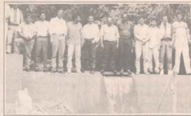
Bocatomá del acueducto de la vereda "La Aguadita".
