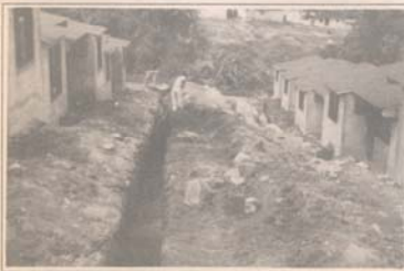
Alcantarillado del barrio Simón Bolívar.
