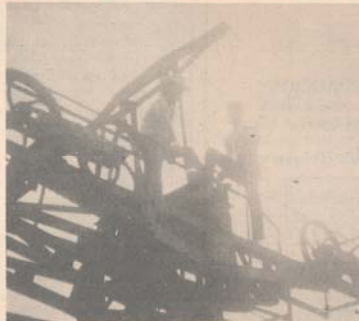
Torre del Cable Aéreo ubicada en el Alto del Cielo.
