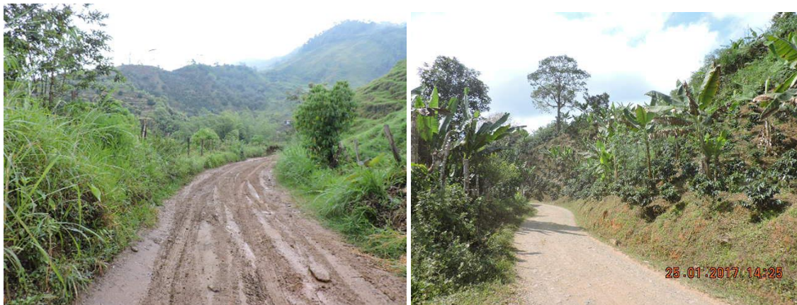
Foto 4. Vías terciarias del Municipio.
