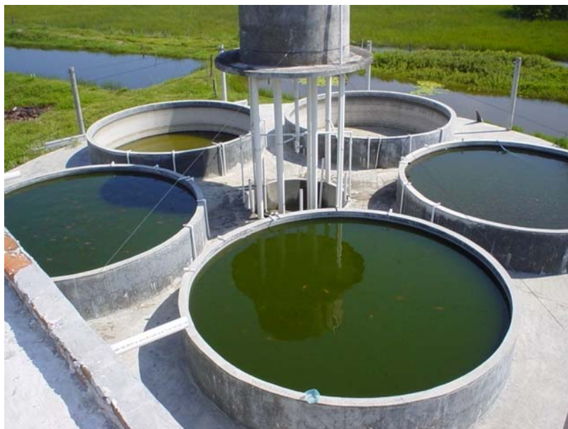
Figura 7. Tanques de concreto
