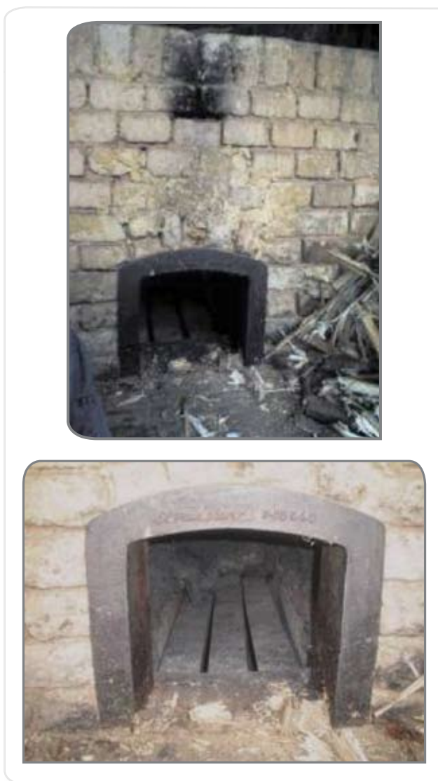
Figura 68. Boca y parrilla del horno
