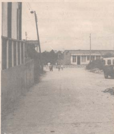
Pavimentación Calle 7 entre carreras 8 y 9
