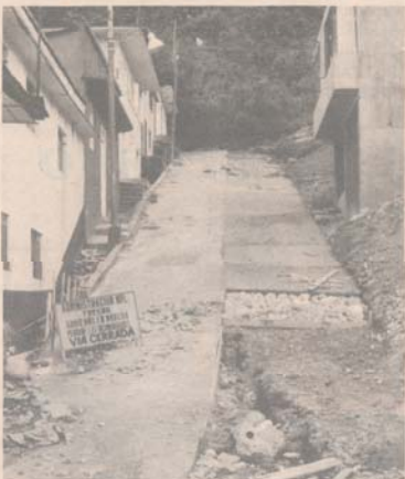
Pavimentación de la carrera 8 entre calles 1a. y 2a. Barrio Centenario
