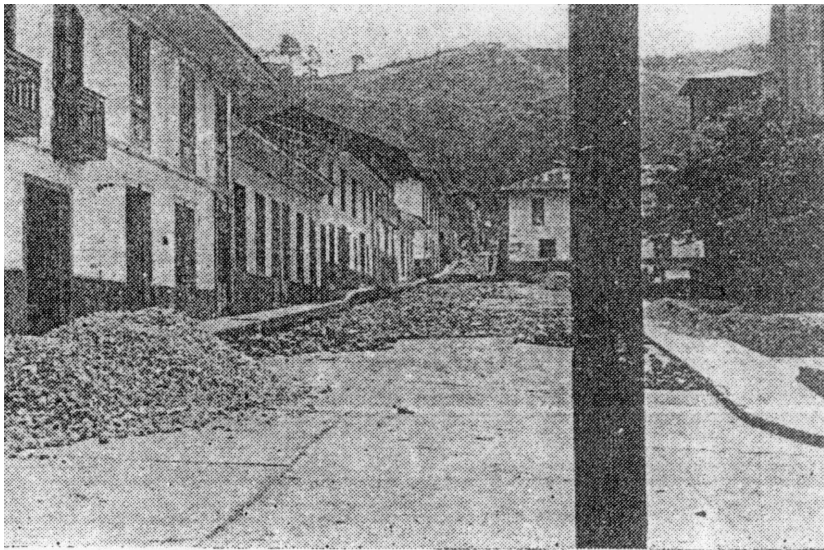
Trabajos de pavimentación
