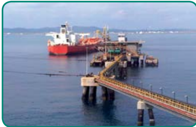
Fig. Nro 70. Puerto petrolero.
