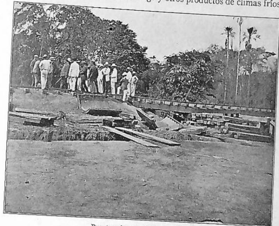
Puente sobre el río Fundación
