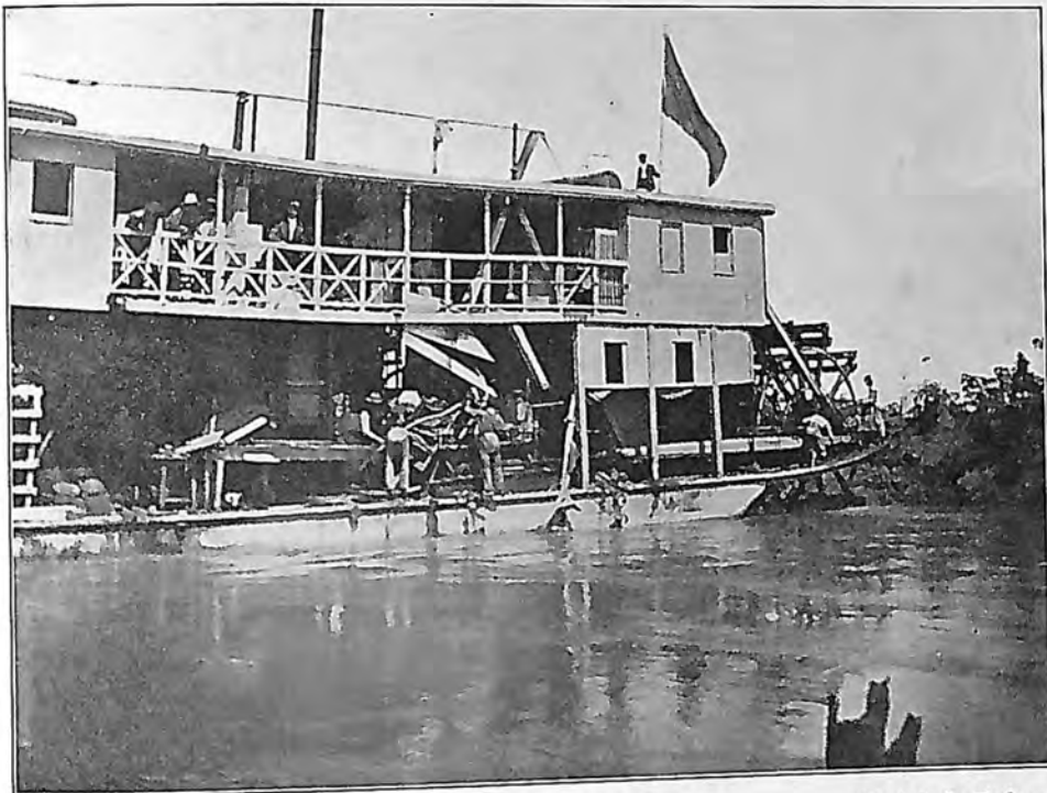
Daños en el vapor "Hércules"
