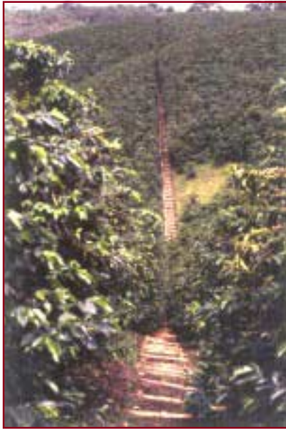
Figura 2. Escaleras hechas en guadua.
