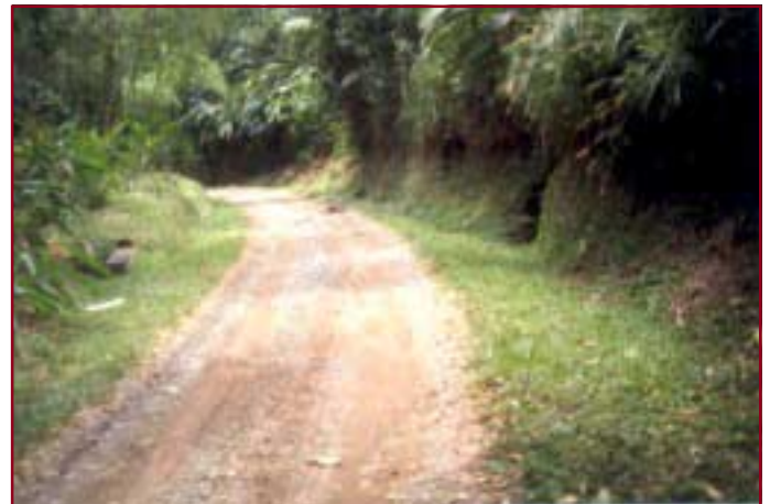
Figura 5. Cuneta protegida con coberturas vegetales de porte bajo.
