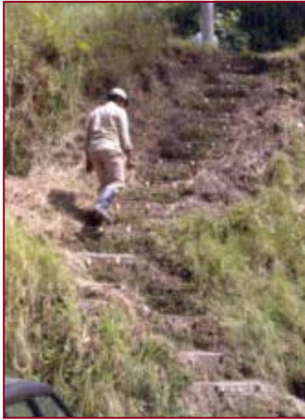
Figura 3. Escalinatas hechas con escombros de construcción.
