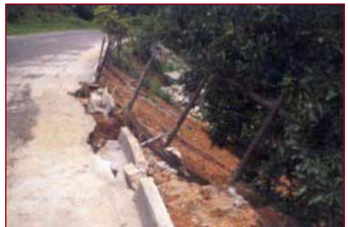
Figura 7. Formación de negativo de carretera.
