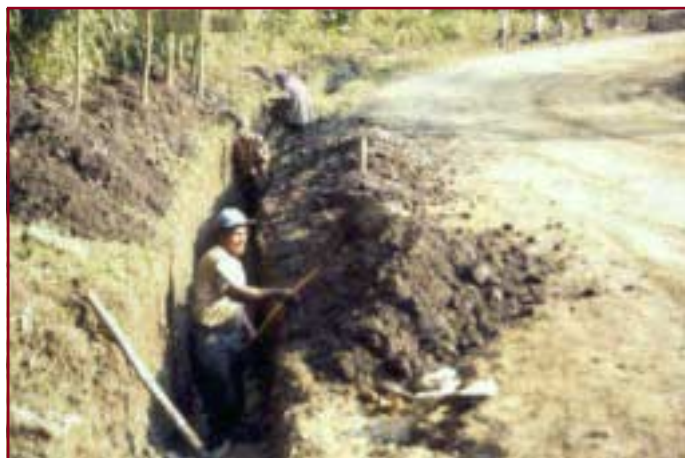
Figura 4. Obras de drenaje para evacuar aguas subsuperficiales.
