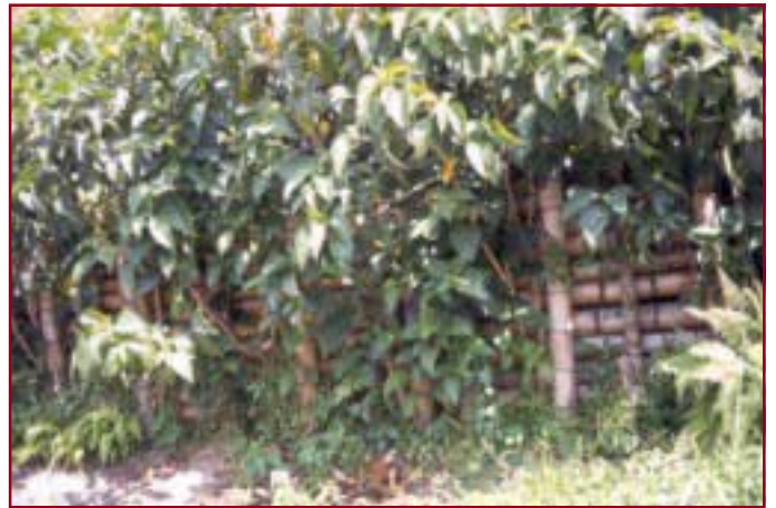
Figura 13. Trinchos reforzados con quebrabarrigo o nacedero.
