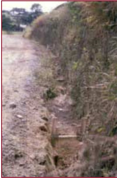
Figura 6. Trinchos utilizados para evitar el socavamiento de cunetas.
