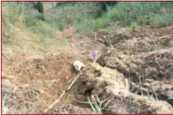
Figura 12. Filtros en guadua para evacuación de aguas dentro de una cárcava.
