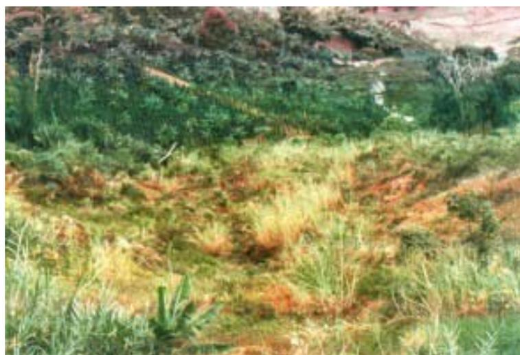
**Figura 9.** Recuperación de Cárcava remontante en fincas providencia y La Aurora en Palestina Caldas. Unidad Chinchiná, Melanudands. Construcción de trinchos escalonados vista desde arriba hacia abajo (Octubre de 1994).
