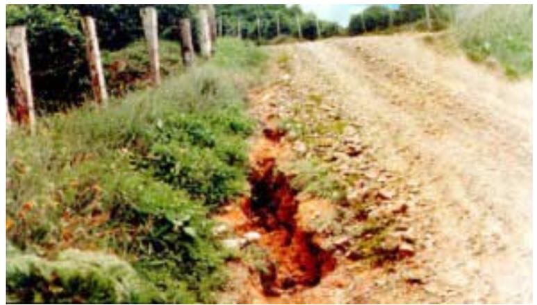
**Figura 2.** Cárcava profunda en cuneta de carretera por ausencia de coberturas vegetales.
