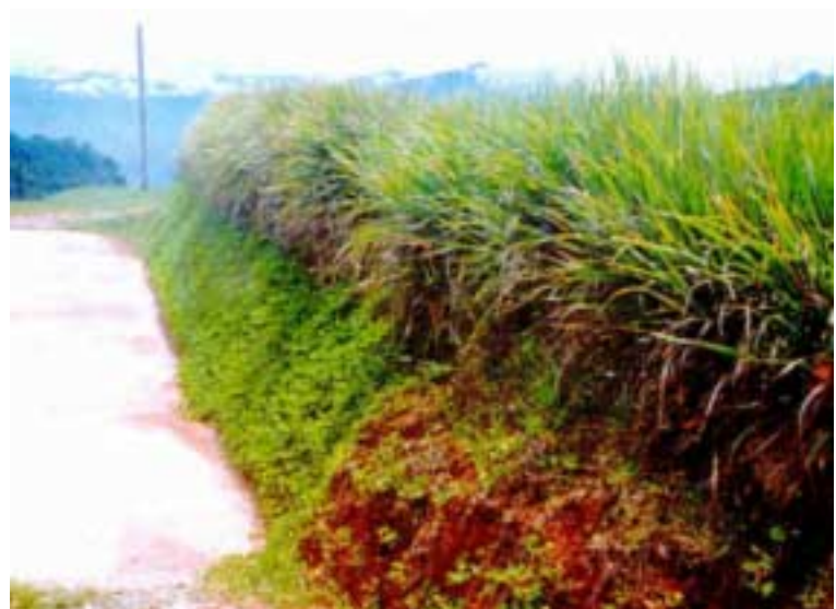
Figura 1. Arachis sp. establecido en un talud, como vegetación protectora contra la erosión.
