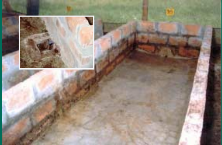
Figura 4. Cama en ladrillo: obsérvese el piso de cemento, con desnivel y desagüe.
