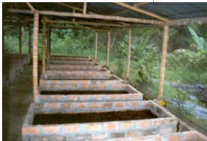
Figura 2. Camas hechas en ladrillo, estructura del techo en guadua y tejas de zinc, en la Central de Beneficio Ecológico de Café en Anserma, Caldas.
