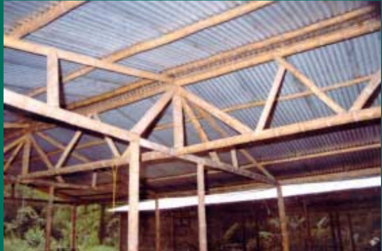
Figura 5. Estructura del techo en guadua y cubierta de zinc.
