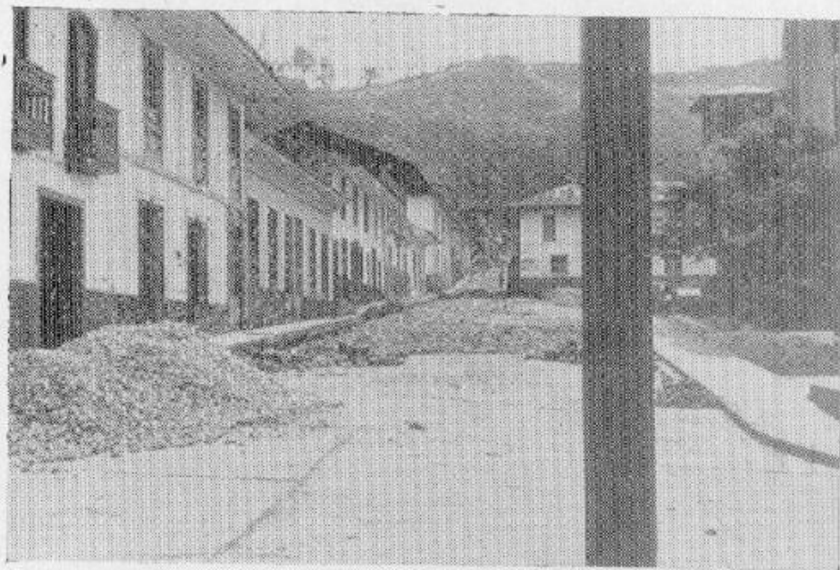
Trabajos de pavimentación
